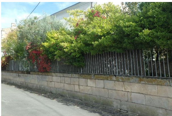
Exemple de mur bahut doublé d'une haie (à conserver)
