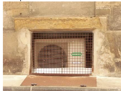
...dans un soubirail, c'est une des solutions possibles
