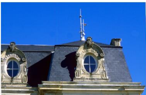
Toit en ardoises et lucarnes
