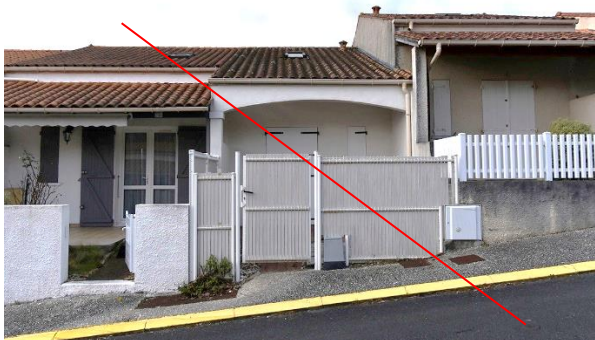
Contre-exemple : mur en canis PVC
